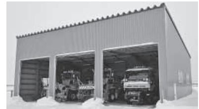
除雪機械車庫整備 3,488万円(土木費)
