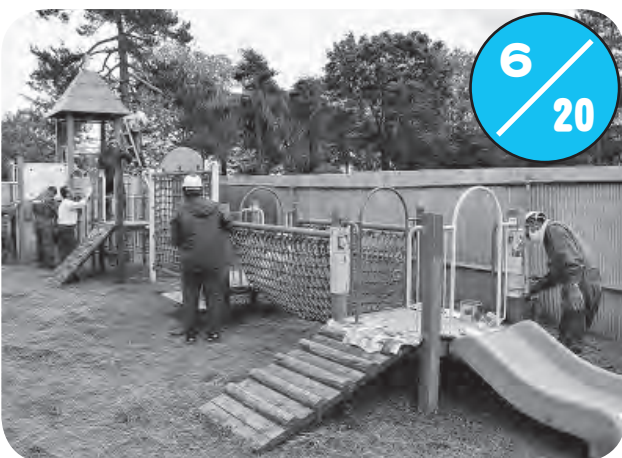
町内9事業所の25名で構成する技能協会（内田隆文会長）が、屋外遊戯場周辺で奉仕作業を行いました。平成21年に設置された遊具のペンキを塗りなおし、新設の遊具にも負けないほどの鮮やかさになりました。
