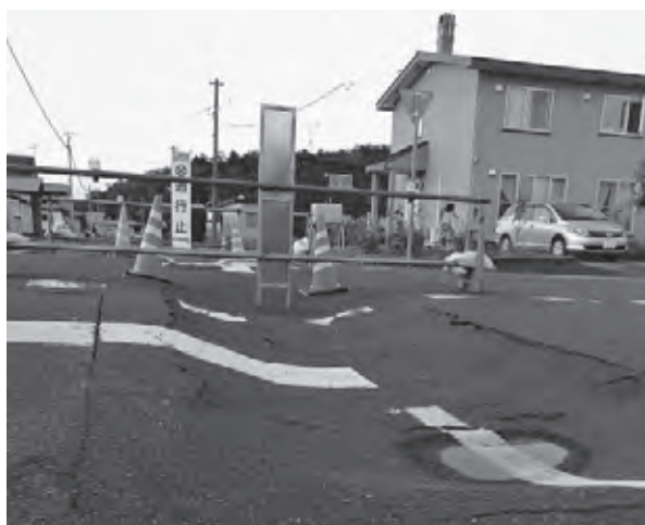
道路が陥没し通行止めとなっている 安平町の様子
